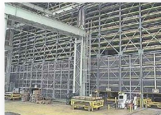
自動ラック倉庫
